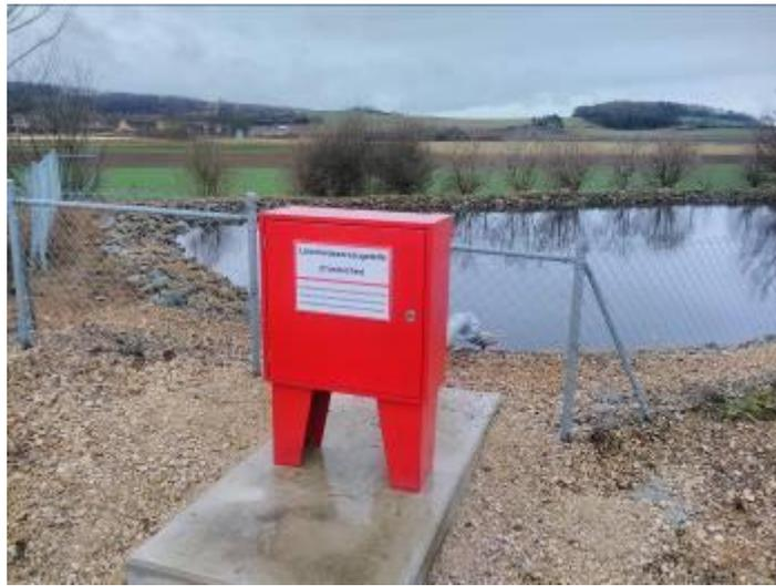
**Abb. 6: Beispiel einer Löschwassersaugstelle (Quelle: Anton Baumann)**
