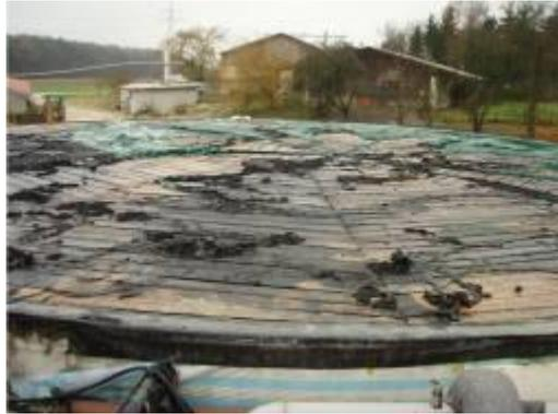
**Abb. 9: Holzdeckenkonstruktion einer Biogasanlage nach Abbrand des Gasspeichers (Quelle: Anton Baumann)**
